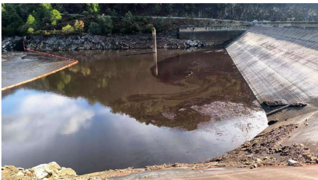
Situación de una presa que abastece a Piedralaves.
