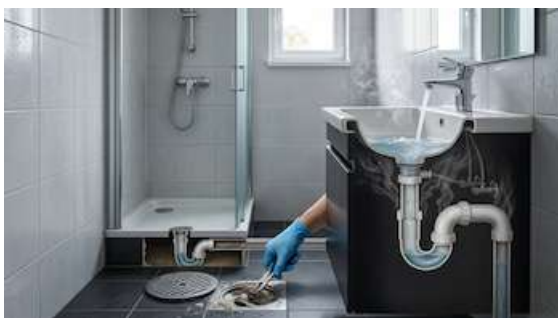
Los lavabos, duchas y bañeras cuentan con curvas que retienen una pequeña cantidad de agua para frenar la entrada de gases. (Imagen Ilustrativa Infobae)
