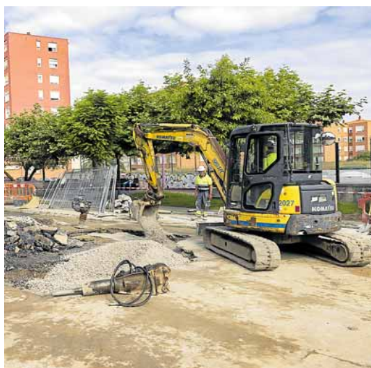
Obras de Aqualia en el entorno del Paseo de Altamira. JUANJO SANTAMARÍA
