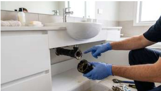
El mal olor del baño puede estar relacionado con atascos, problemas de ventilación, averías en el inodoro, defectos de sellado o envejecimiento de las tuberías. (Imagen ilustrativa Infobae)
